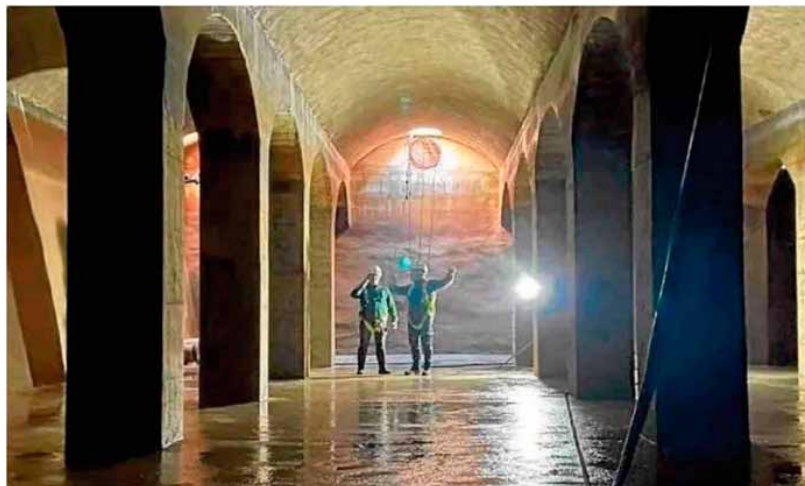
Uno de los depósitos de agua de El Vendrell. FOTO: DT
