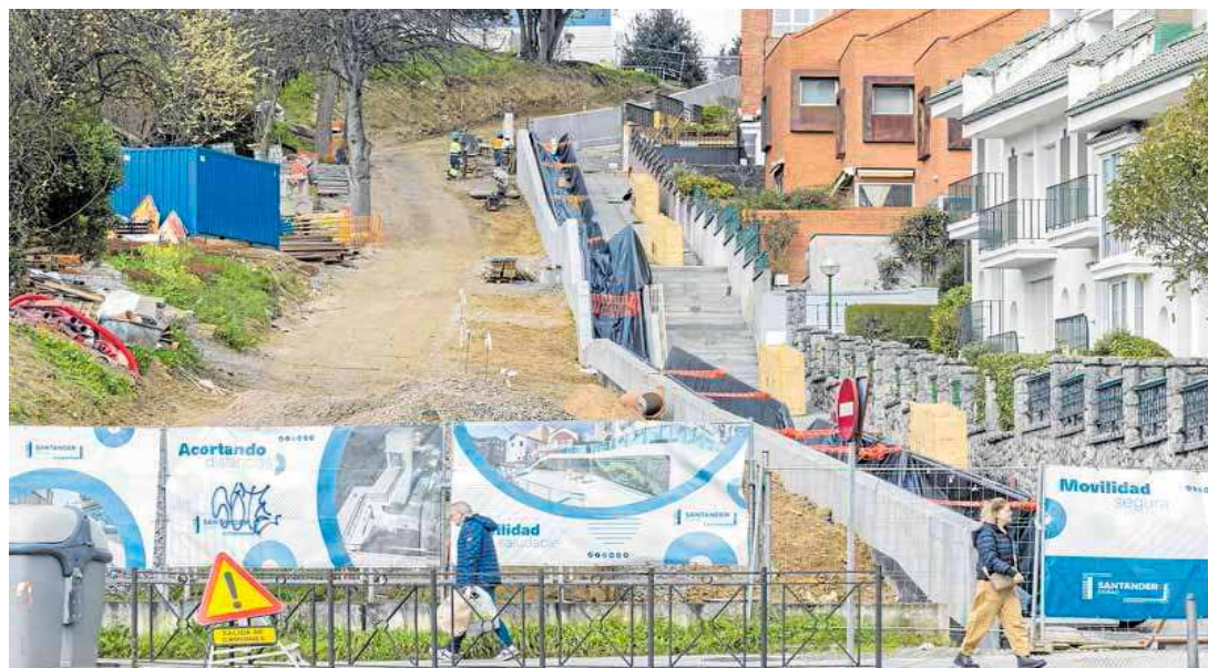
Estado, ayer, de los trabajos del itinerario mecánico que conectará Valdecilla y Cardenal Herrera Oria. ROBERTO RUIZ
